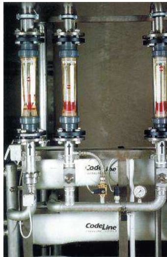
Fordított ozmózis berendezés rotamétere (áramlásmérő)
