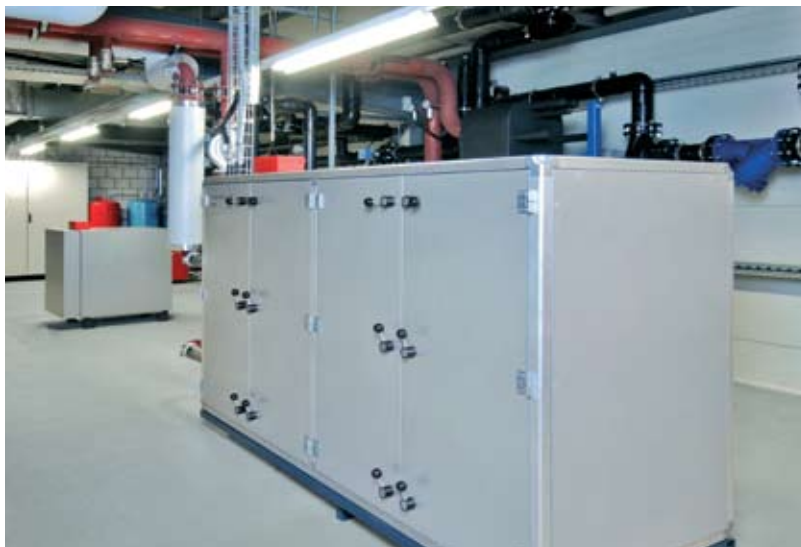
Fűtőhelyiség hőszivattyúkkal
